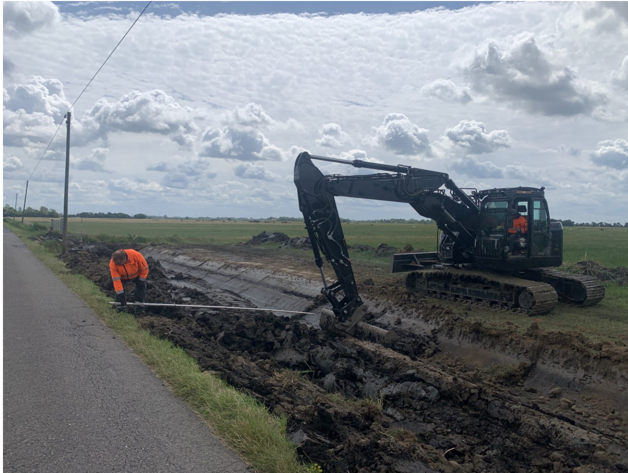
Wegeverbreiterung im Verfahren Stollhammerwisch Ost (2023)
